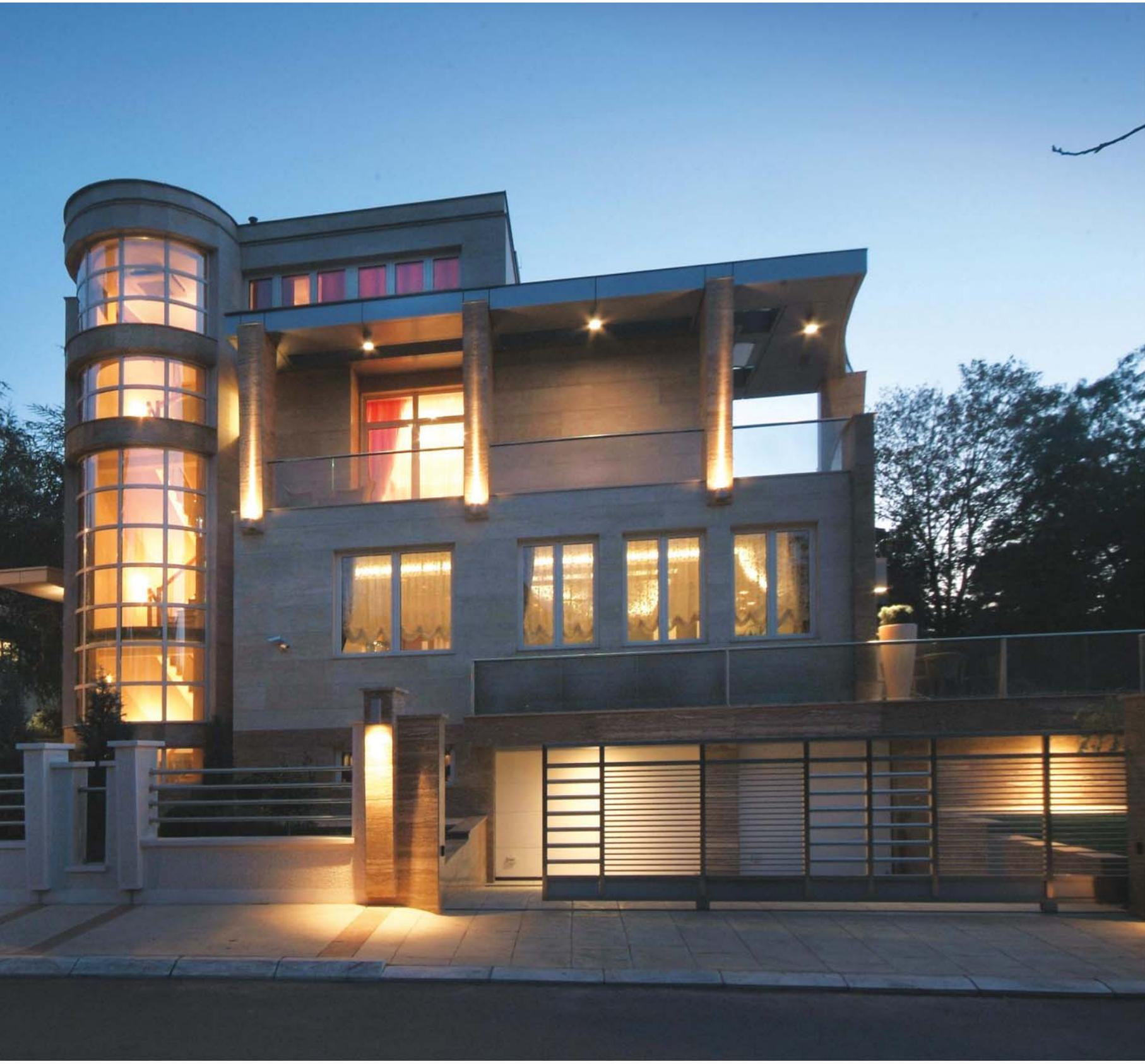
horizontalni akcentujući elementi (sokl, venci, grede) oplaćeni su tamnjim, italijanskim travertinom u mat teksturi. Između ostalog, specifičnost objekta je i u tome što i staklene površine u potpunosti prate formu objekta, što se odlično uočava na zatalasanom platnu zadnje fasade i stepenišnom aneksu.
